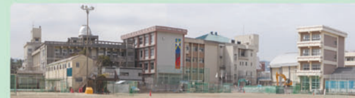
壁面が色鮮やかな新理科学館と解体された高校校舎
